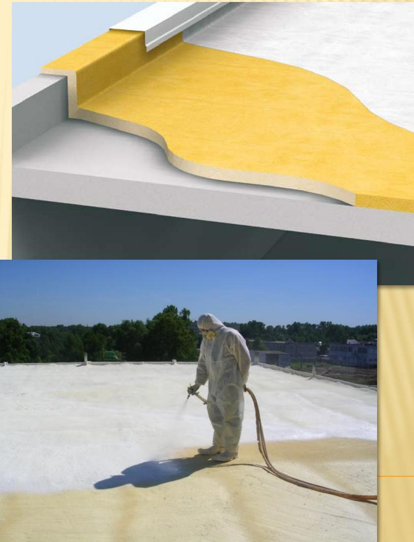
Как и в случае с изоляцией монолитных плоских крыш, **изоляция плоских крыш из профнастила** является одним из традиционных способов применения ППУ. Кровли складов, производственных помещений, выставочных и спортивных залов, как правило, изготовлены из профилированных металлических листов и имеют сравнительно большие пролеты. Эти легкие кровельные конструкции требуют изоляции легкими материалами, чтобы иметь возможность выдерживать дополнительные нагрузки из-за ветра, дождя и снега.
