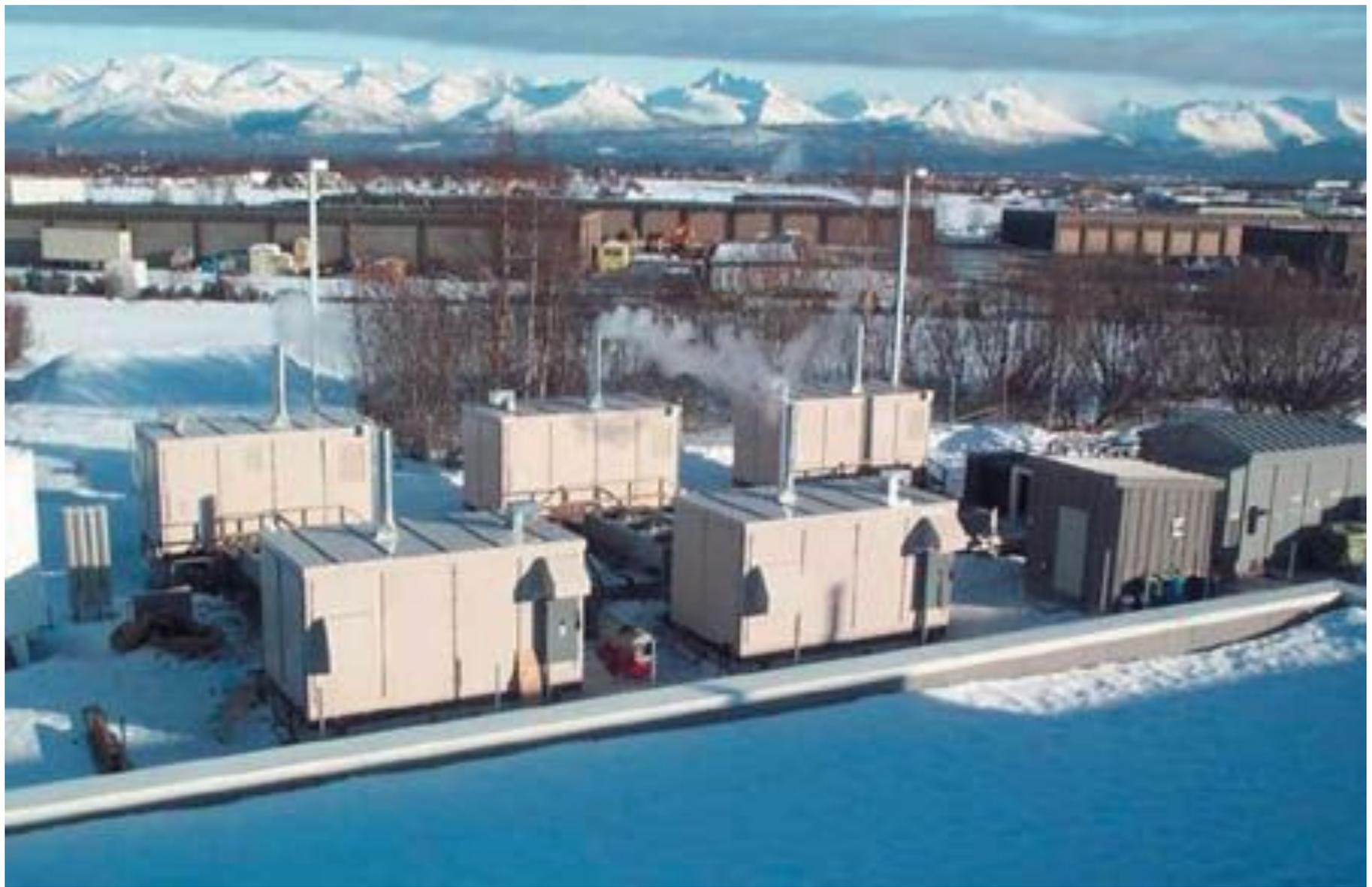
Система энергоснабжения почтовой службы США на основе пяти топливных элементов «PC25» производства «ONSI Corporation» (сейчас «United Technologies, Inc.»), Анкоридж, Аляска, 2001
