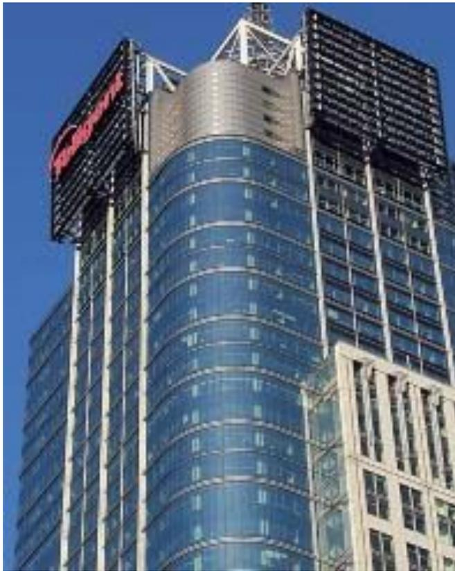
**Верхние этажи здания с интегрированными фотоэлектрическими панелями**
