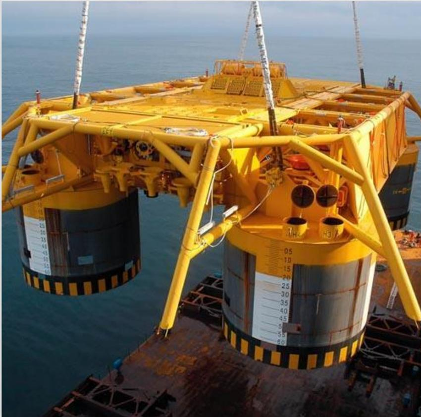
После окончания бурения на донную плиту был помещен подводный добычный комплекс (ПДК). Он включает в себя манифольд (на фото слева), устьевое оборудование скважины, тройник, оконечное устройство, шлангокабель и другие необходимые элементы.
