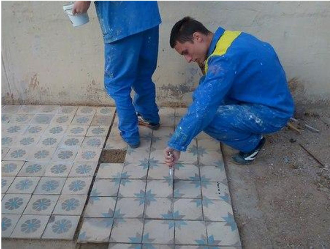
Зачистка швов (Завершение)
