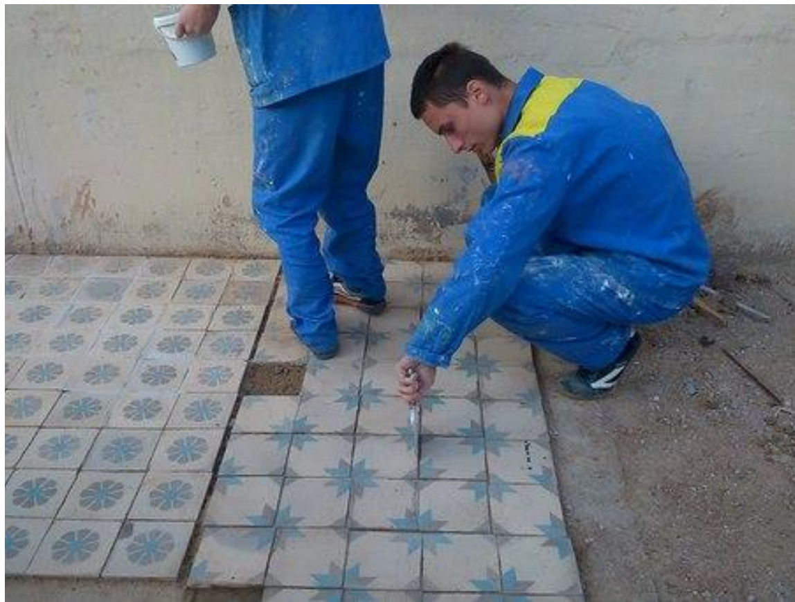
Зачистка швов (Завершение)
