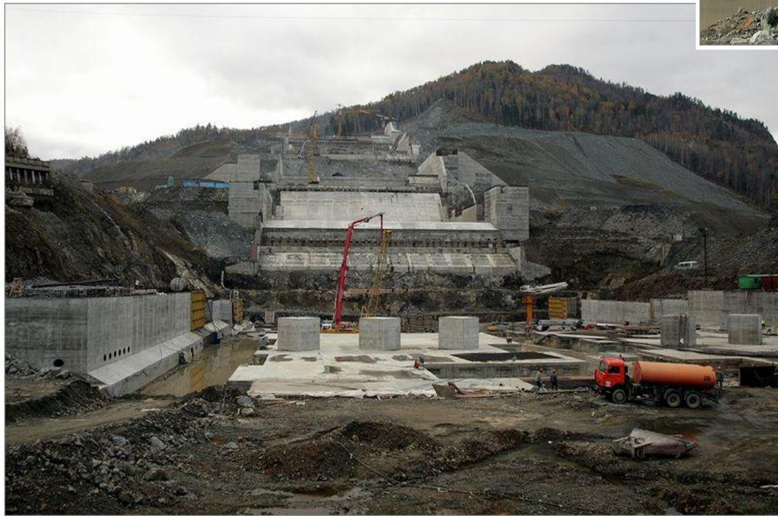
В состав сооружений берегового водосброса входят: входной оголовок, два безнапорных туннеля сечением 10x12 м длиной 1130 метров каждый, выходной портал, пятиступенчатый перепад и отводящий канал.
