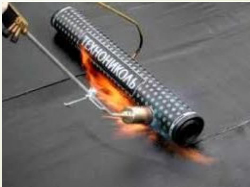
**Кровельный ковёр из наплавляемых рулонных материалов необходимо наклеивать на основание методом расплавления или разжижения (пластификации) мастичного слоя.**
