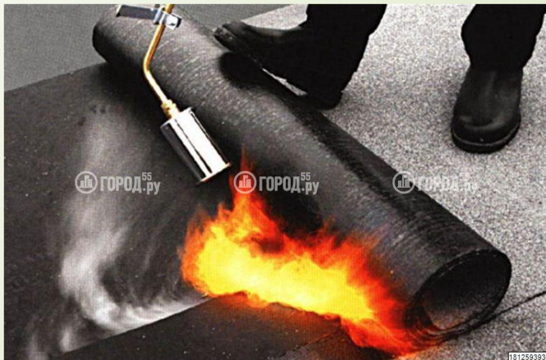
□ **Рулонные наплаваемые кровельные материалы** состоят из стекловолокнистой или полиэфирной основы, покрытой с двух сторон слоем битумно-полимерного вяжущего.
