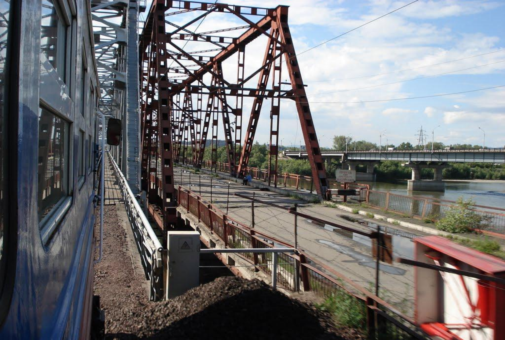
Мост через реку Абакан.
