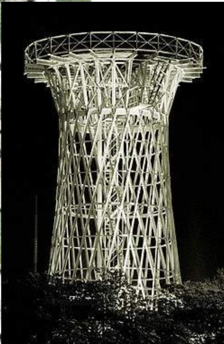
**Водонапорная башня системы В. Г. Шухова построена в 1928-30 гг. Одна из первых в мире гиперболоидных конструкций и одна из семи сохранившихся башен системы инженера Шухова.**
