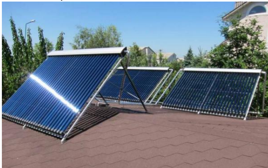
Конструкція вакуумного сонячного колектора
