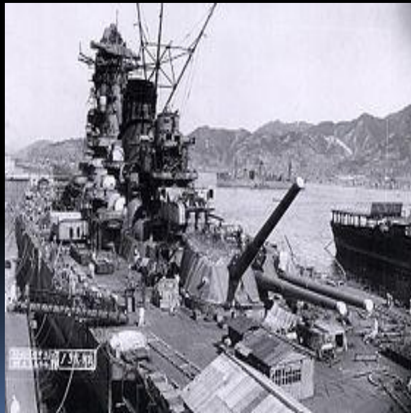
Кормовая башня линкора «Ямато» во время его постройки
