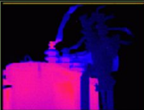
Нагрев шпильки ввода силового трансформатора
