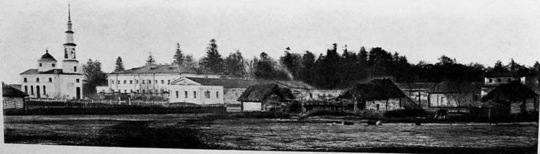
... Если подъѣзжать изъ Пензы, виденъ домъ и флигель, отъ котораго тянутся каменные постройки; башня, которая видѣется сзади — на бывшемъ конномъ дворѣ...
