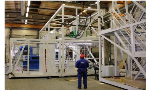
Строительство модулей завода Modul25
