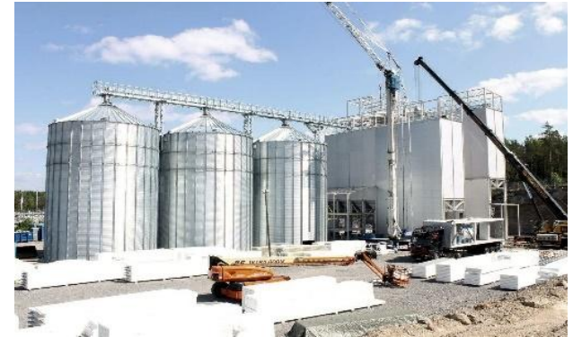
Строительство завода Agrox в Финляндии
