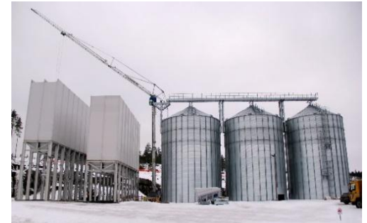
Параллельное строительство завода Modul25 на объекте
