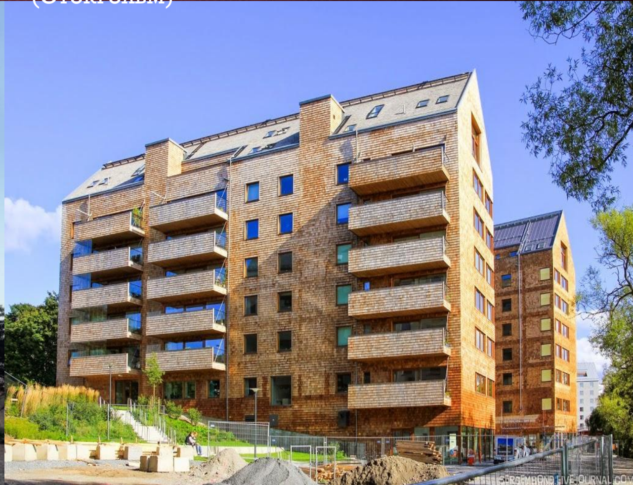
Жилой многоэтажный деревянный дом (Стокгольм)
