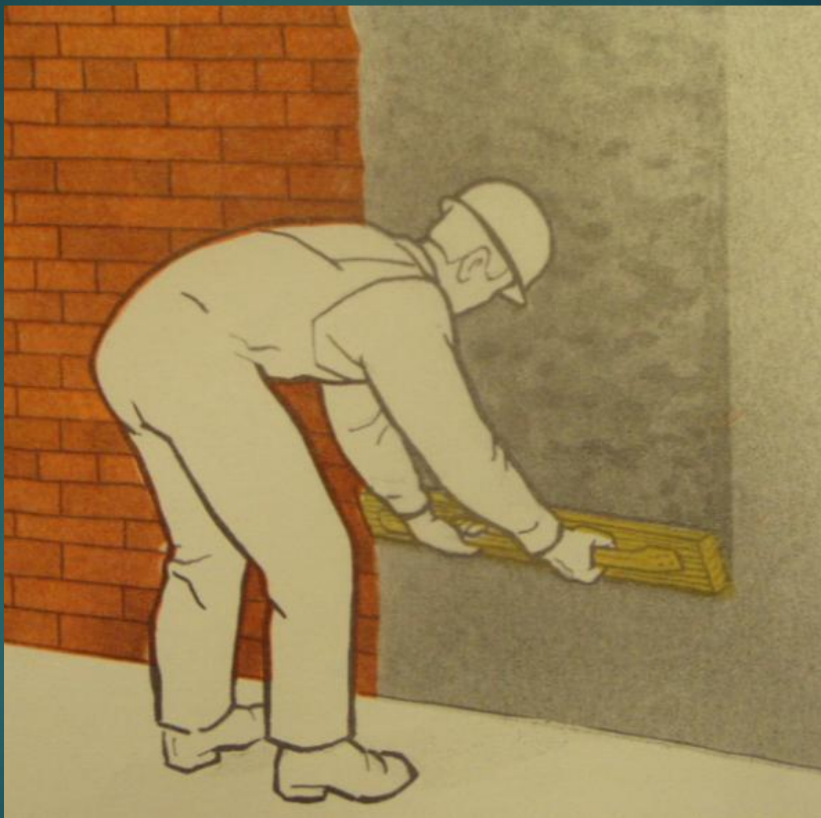
Разравнивание грунта
