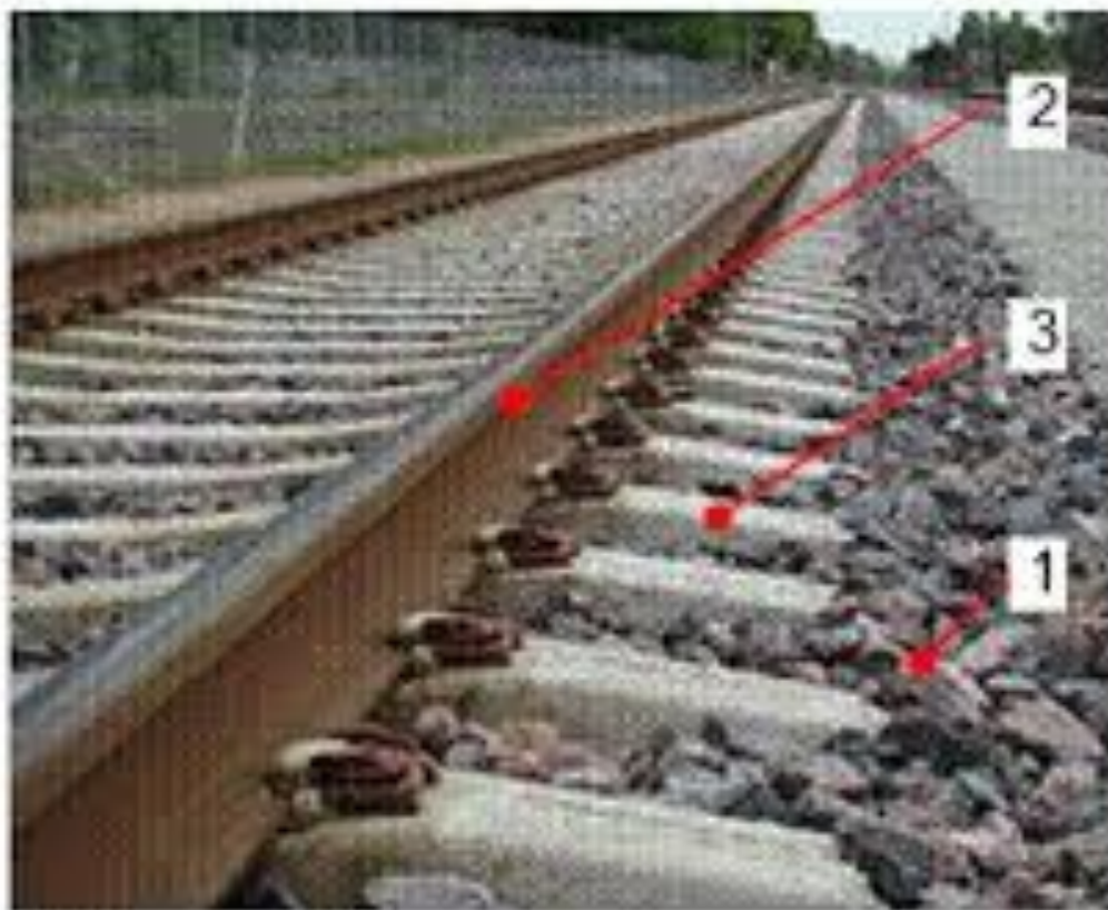
Рис. 2.5. Элементы ВСП. 1 – балластный слой; 2 – рельсы со скреплениями 3 – шпалы;
