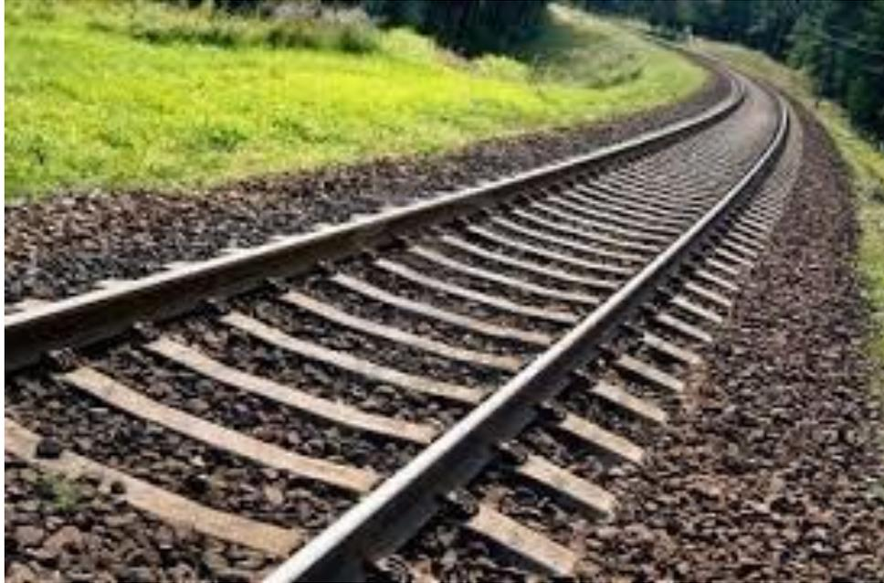
ВСП служит для направления движения подвижного состава, восприятия нагрузки от его колес и передачи ее на нижнее строение
