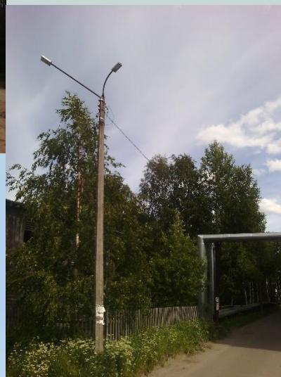
Общественная территория после выполнения работ
