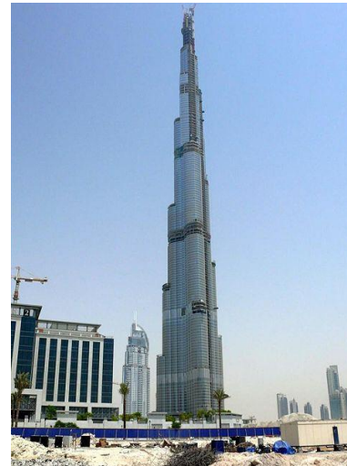
Высотные здания и сооружения
