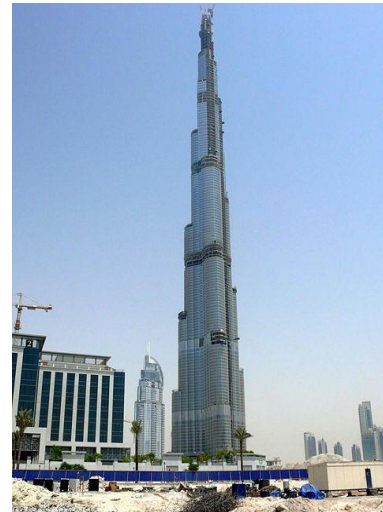
Высотные здания и сооружения
