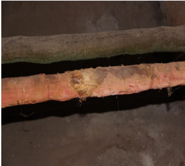
Подвал жилого дома.
