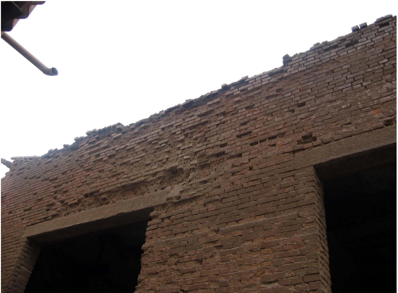
Сильная эрозия кладки карниза и стены.
