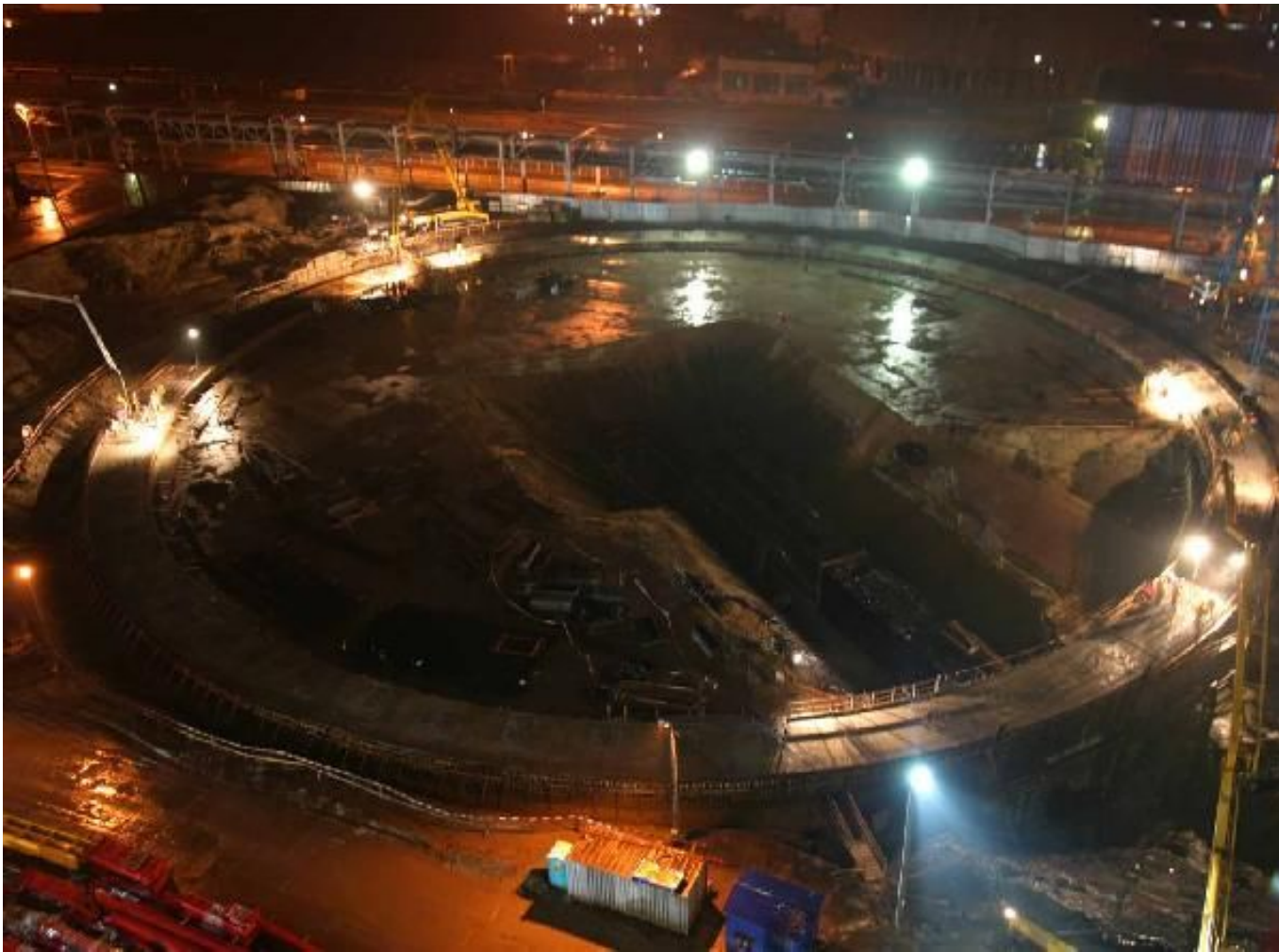
Бетонирование опорного кольца
