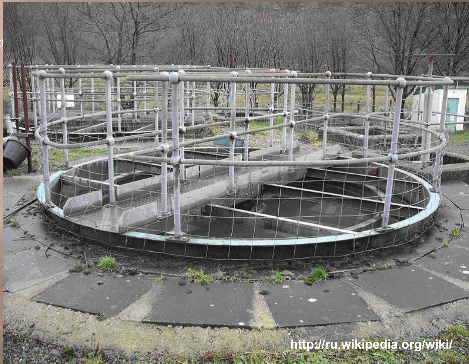
Танк-отстойник первичной очистки
