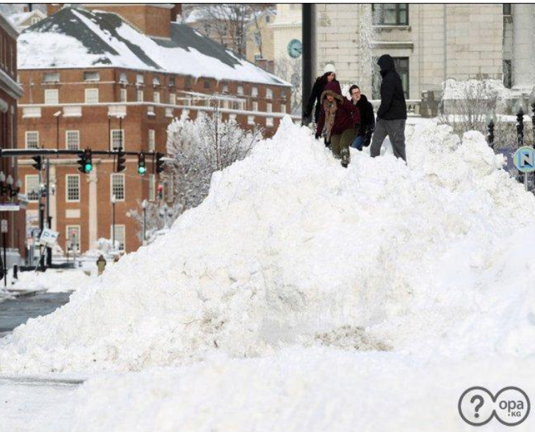
сгребании в валы снег уплотняется в 2,5-3 раза
