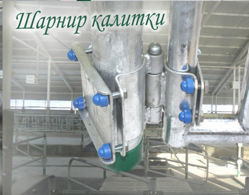
Узел крепления надхолодной трубы боксовых перегородок УЗН-65"КРАБ"
