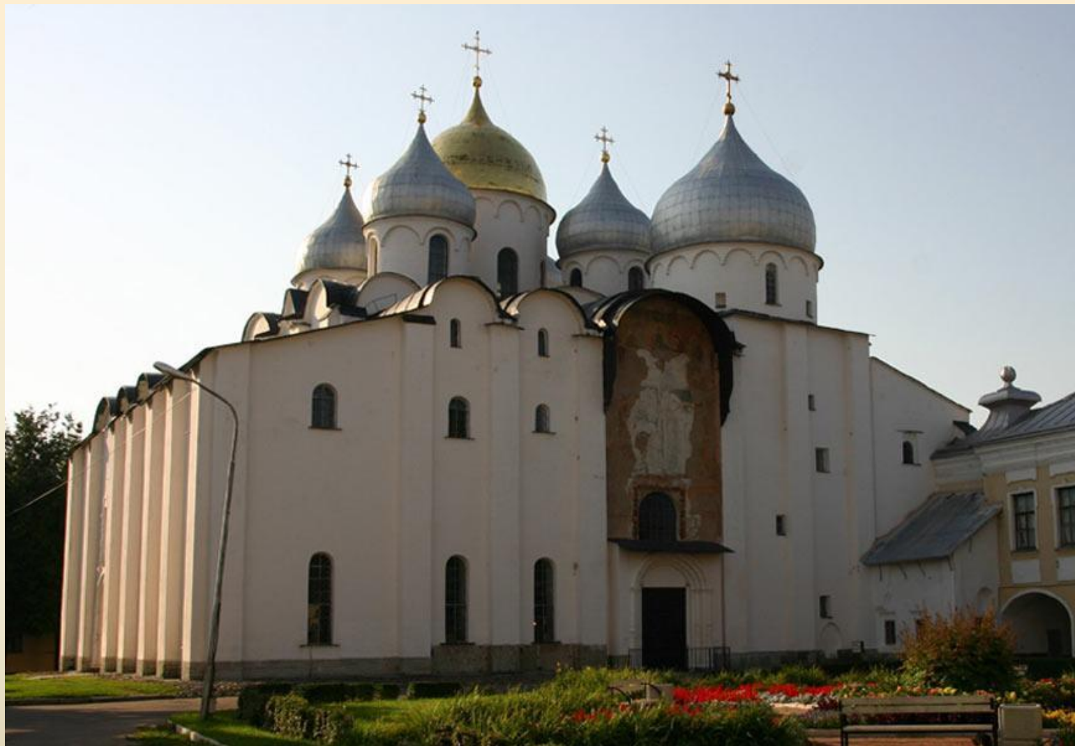
Софийский собор в Новгороде. Западный фасад
