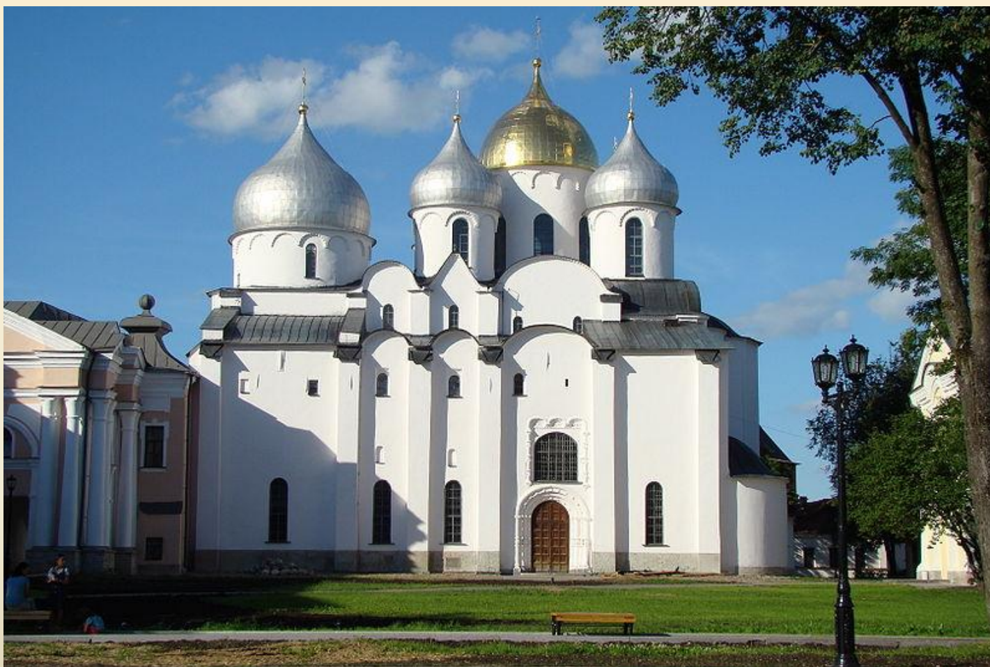
Софийский собор в Новгороде. Южный фасад
