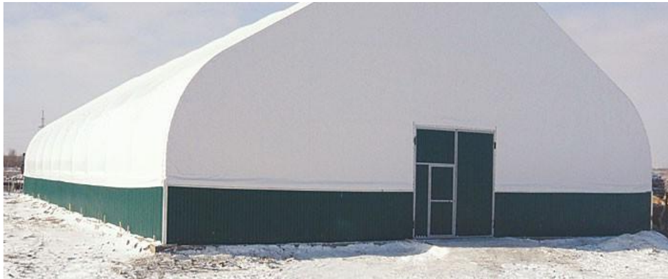
Навес над площадкой
