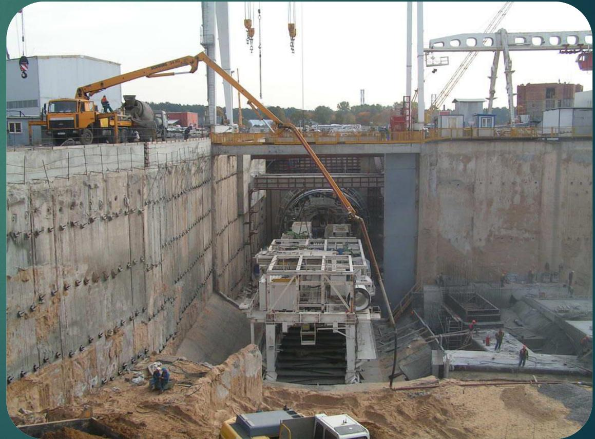
**Траншейный способ**, при котором котлован разрабатывают по частям (в этом случае для устройства вертикальных стен тоннеля используют способ «стена в грунте»). Таким способом часто строят пешеходные тоннели;
