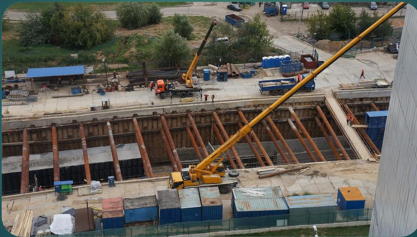
При открытом способе строительства тоннелей, поверхность вскрывается, тоннельные конструкции возводятся в котловане со свайными креплениями или откосами. Городские подземные коммуникации перекадываются, движение наземного транспорта отводится в сторону. Основания и фундаменты зданий вблизи трассы при необходимости укрепляются.
