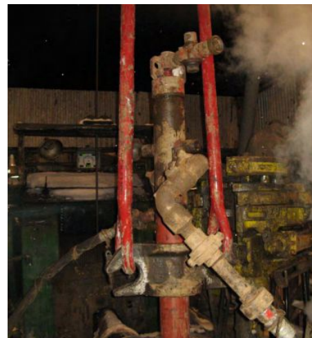
Вид удлиненных штопоров и гибких тампонажных рукавов,
