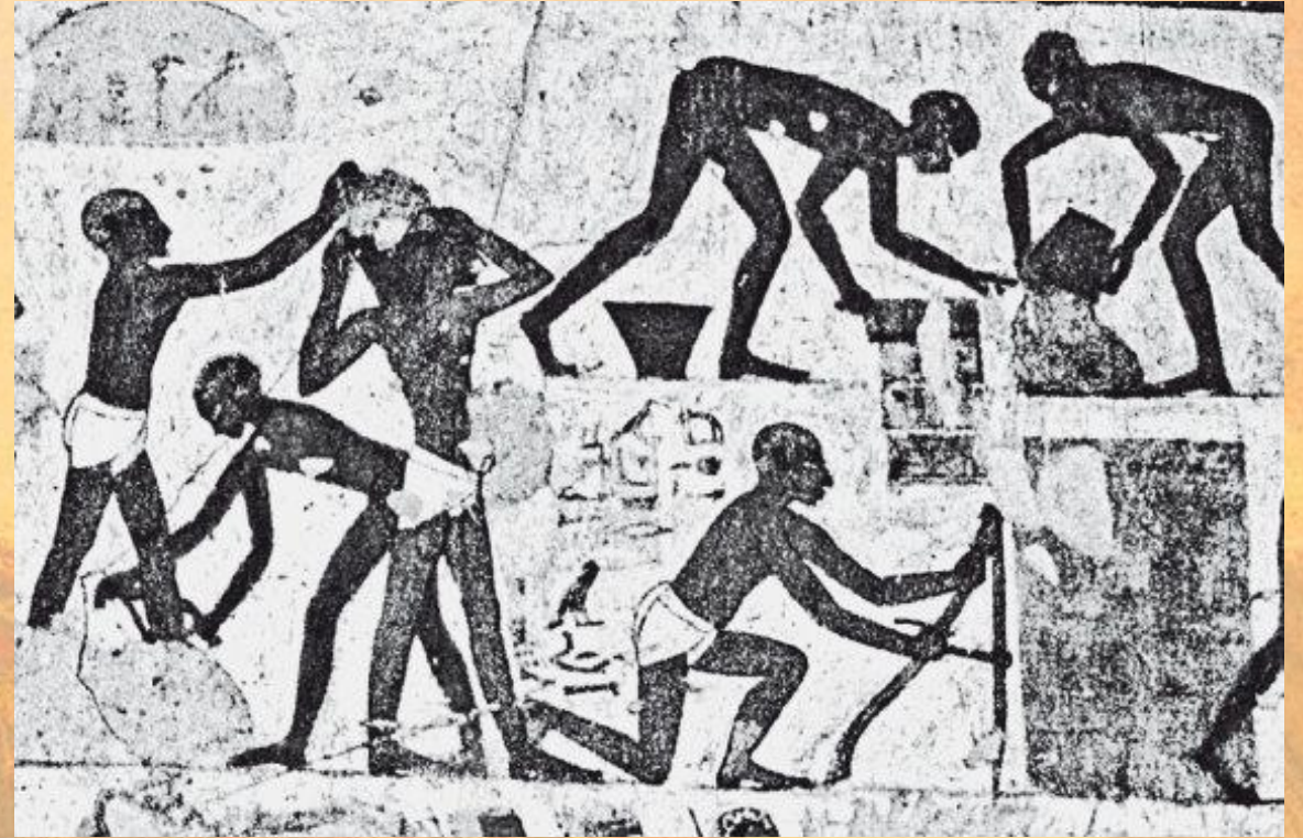
Отливка блоков из известнякового бетона
