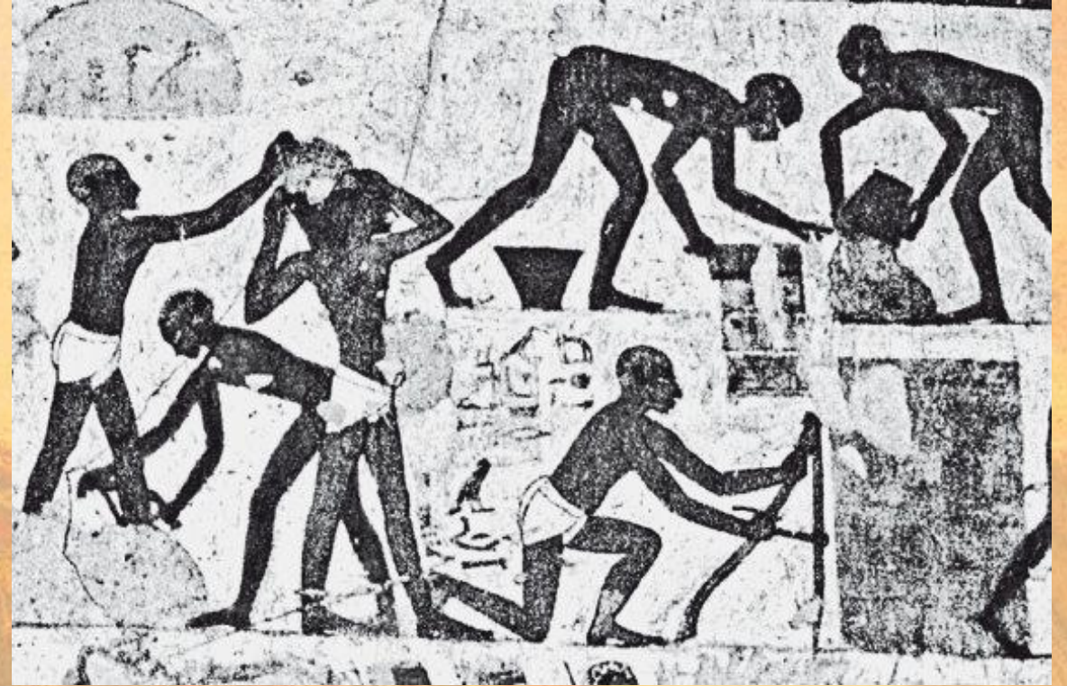
Отливка блоков из известнякового бетона
