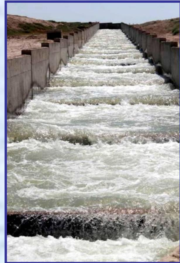
Ступенчатый перепад позволяет прокладывать водоподающие сети по крутым склонам. Помимо основной функции, в рыбоводных хозяйствах выполняет роль аэратора, так как вода, падая со ступенек, хорошо насыщается кислородом воздуха.
