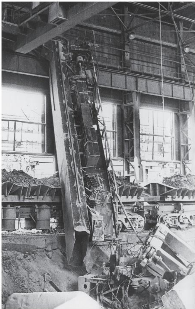
Рис. 5. Место аварии мостового магнитно-грейферного крана грузоподъемностью 15 т
