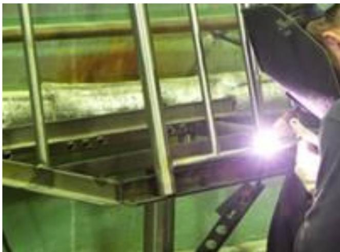
После окончания сварки или обрыва дуги аргон должен подаваться, пока металл не остынет до  $\sim 400^\circ\text{C}$ .
