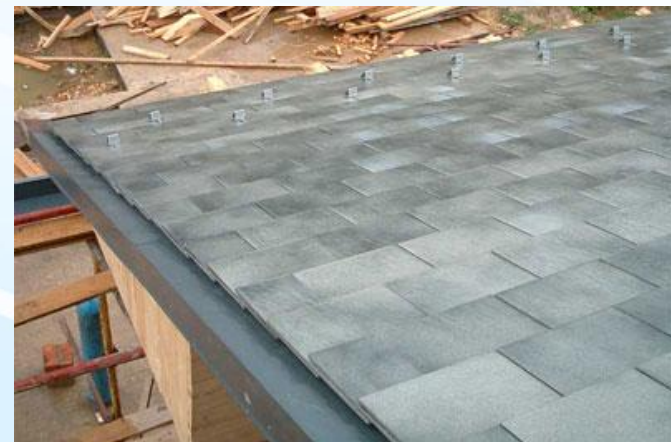
Монтаж плиток формата 25x40 со стороны торцевой планки
