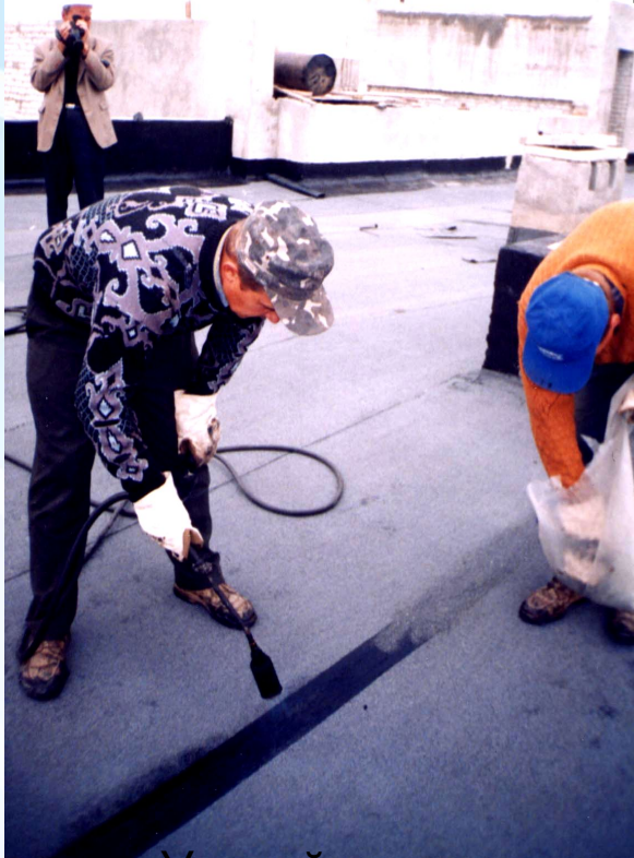
Устройство кровельного ковра
