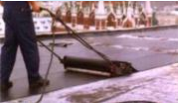
Кровельная машина «Луч» для укладки рядовой поверхности кровли
