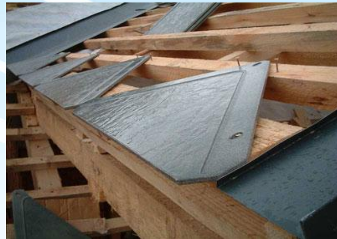
Монтаж первого ряда плиток формата 40x40.
