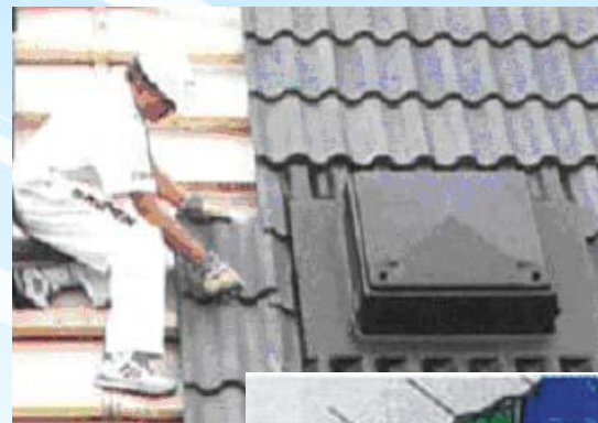
Примыкание черепицы к вентиляционному люку
