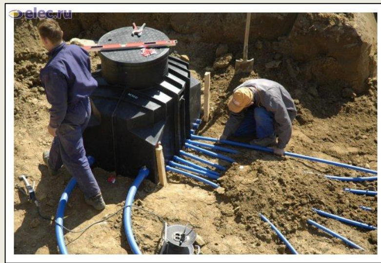
Рис. 5. Отбор тепла из подземных вод.
