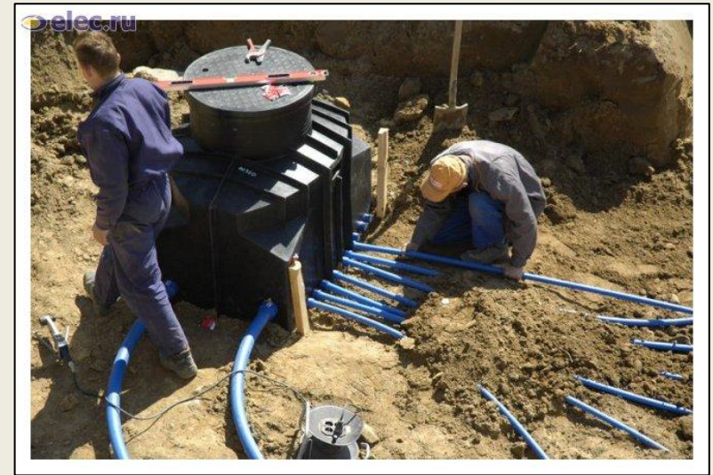
Рис. 5. Отбор тепла из подземных вод.
