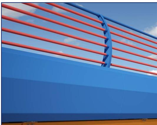
Перильное ограждение – это ограждающая конструкция, обеспечивающая безопасное движение пешеходов по тротуарам и служебным проходам мостового сооружения.
