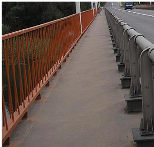
Тротуар мостового сооружения – это несущая конструкция мостового полотна, предназначенная для движения пешеходов в населенных пунктах
