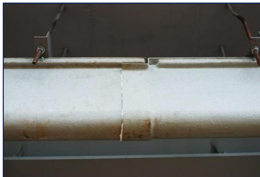
Система водоотведения мостового сооружения – это комплекс конструктивных решений, состоящий из системы элементов, встроенных или закрепленных к конструкциям мостового сооружения и обеспечивающих сбор и удаление воды с мостового полотна далее в водосточную систему
