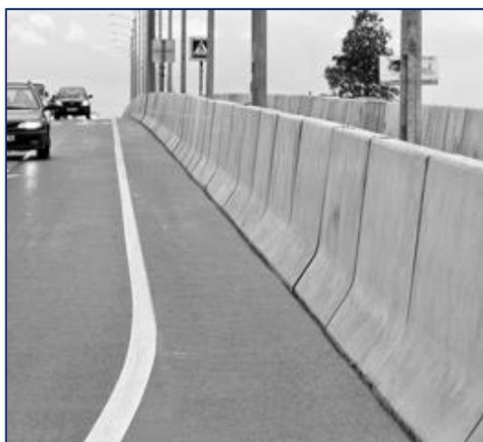
Мостовое ограждение – конструктивный элемент мостового полотна, устанавливаемый на границах габарита приближения строений, предназначенный для предотвращения съезда транспортных средств за его пределы и исправления траектории движения автомобиля при наезде на ограждение.
