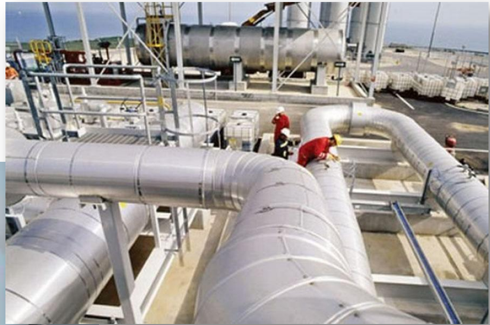
Сооружение трубопровода пара и горячей воды
