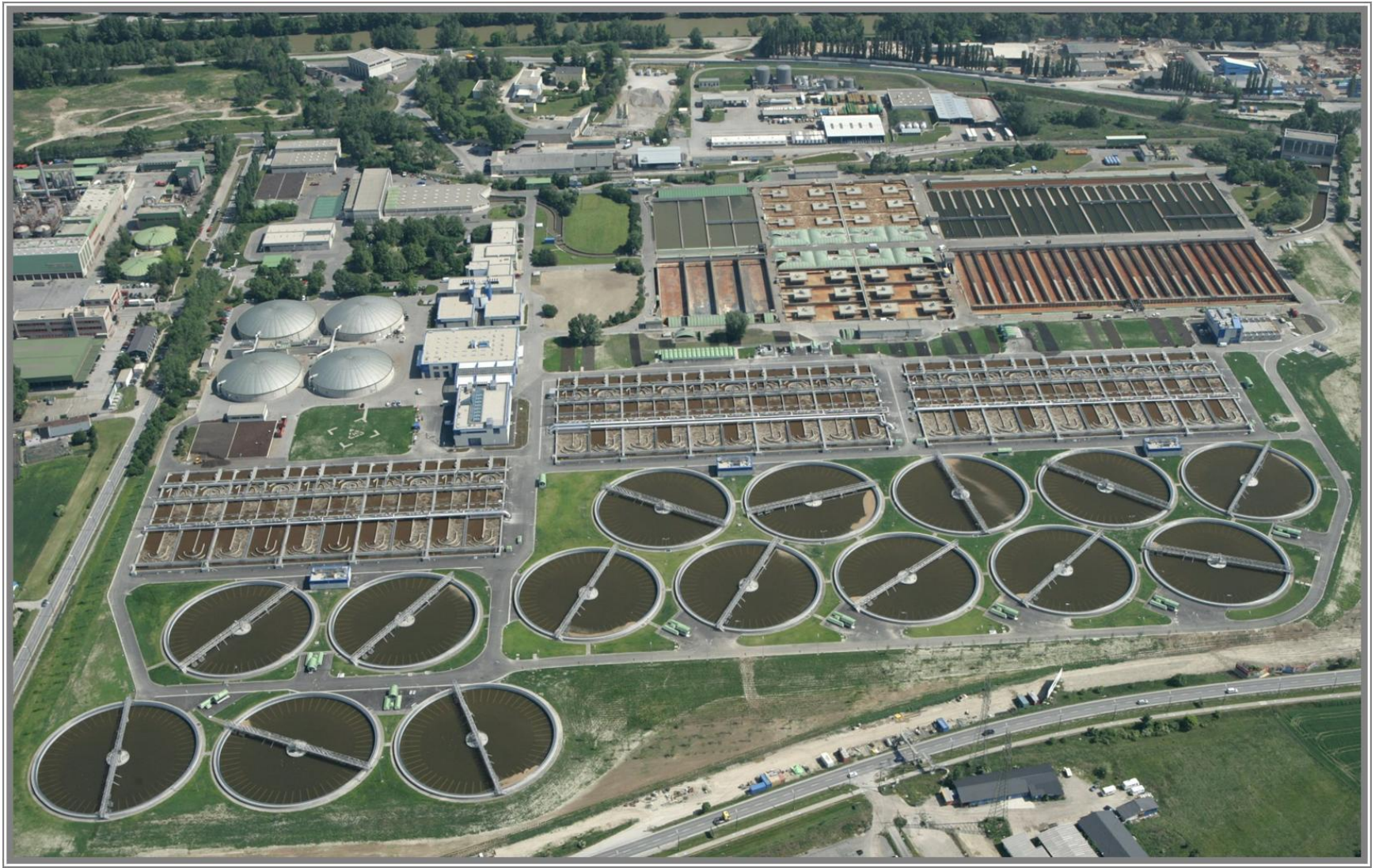
Городские очистные сооружения
