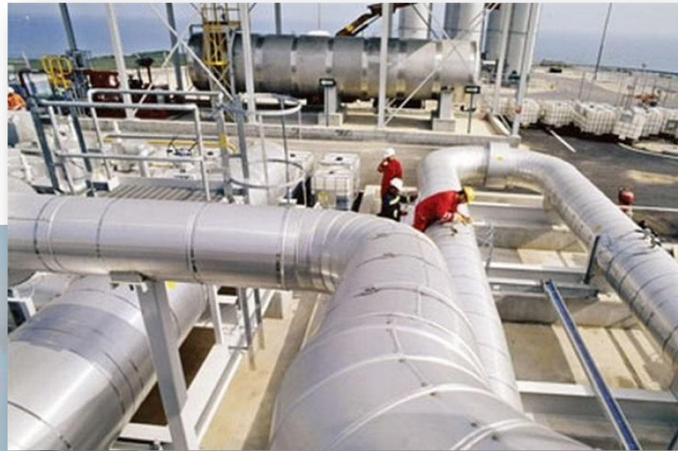
Сооружение трубопровода пара и горячей воды
