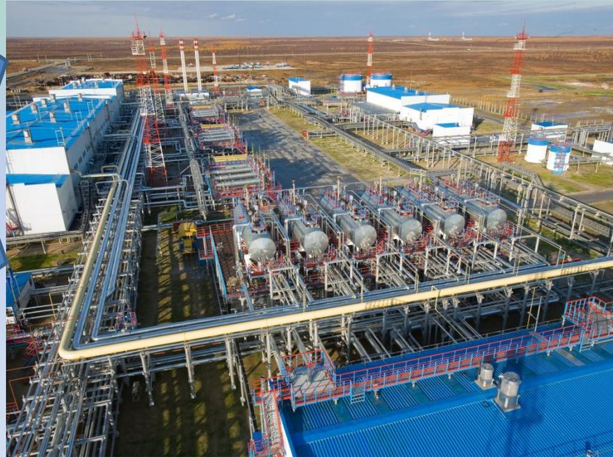
На УКПГ газ очищают от мехпримесей (частицы разрушенного пласта - песок) и осушают от капельной жидкости, удаляя влагу. На ДКС повышают давление газа, обеспечивая его транспортировку.
