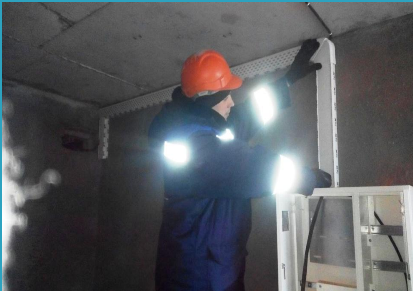
Монтаж электроцита офиса.
