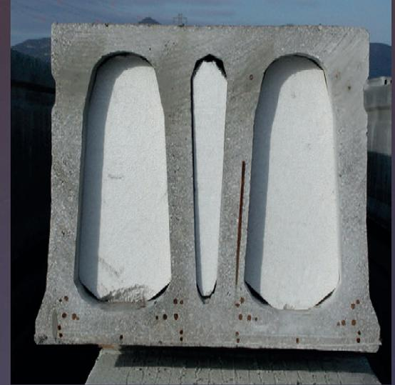
*Плиты покрытия (перекрытия) высотой 1000 мм с видимой преднапряженной арматурой и поперечной стальной арматурной сеткой*
