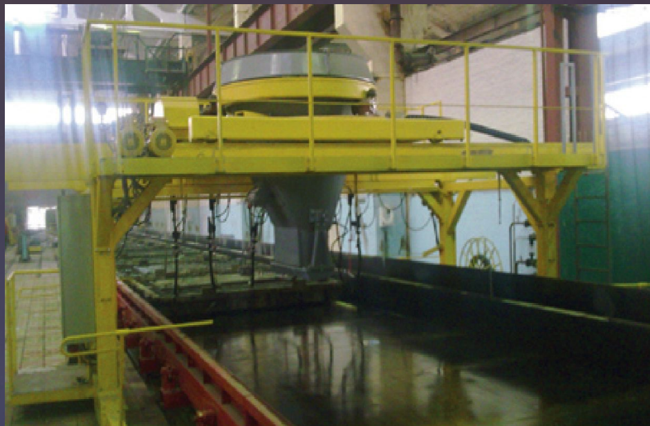
Бетоноукладчик на универсальном стенде
