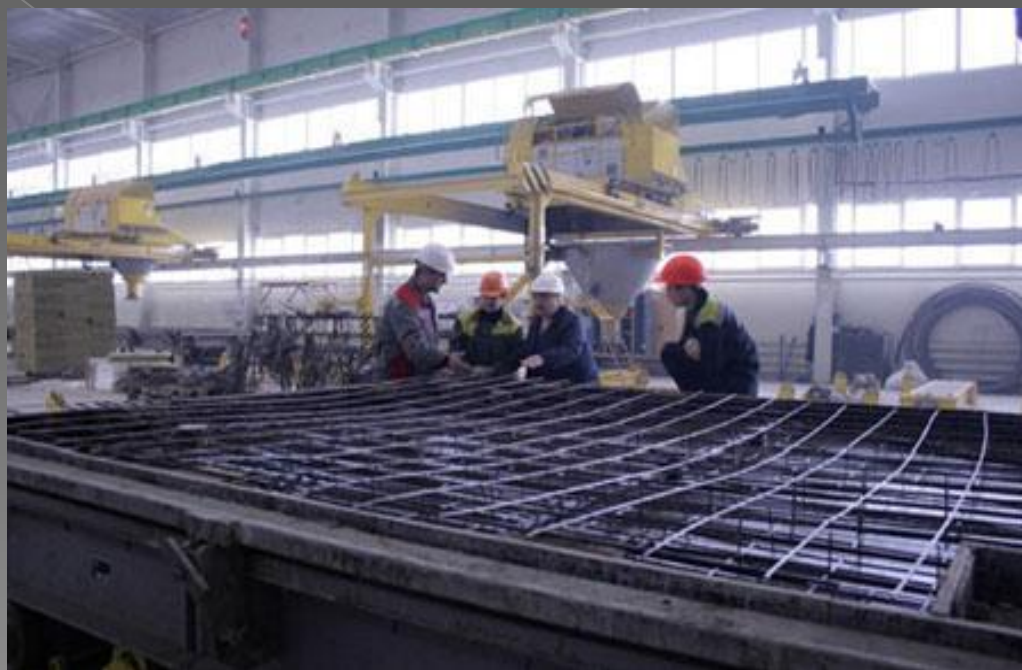
Установка арматурного каркаса
