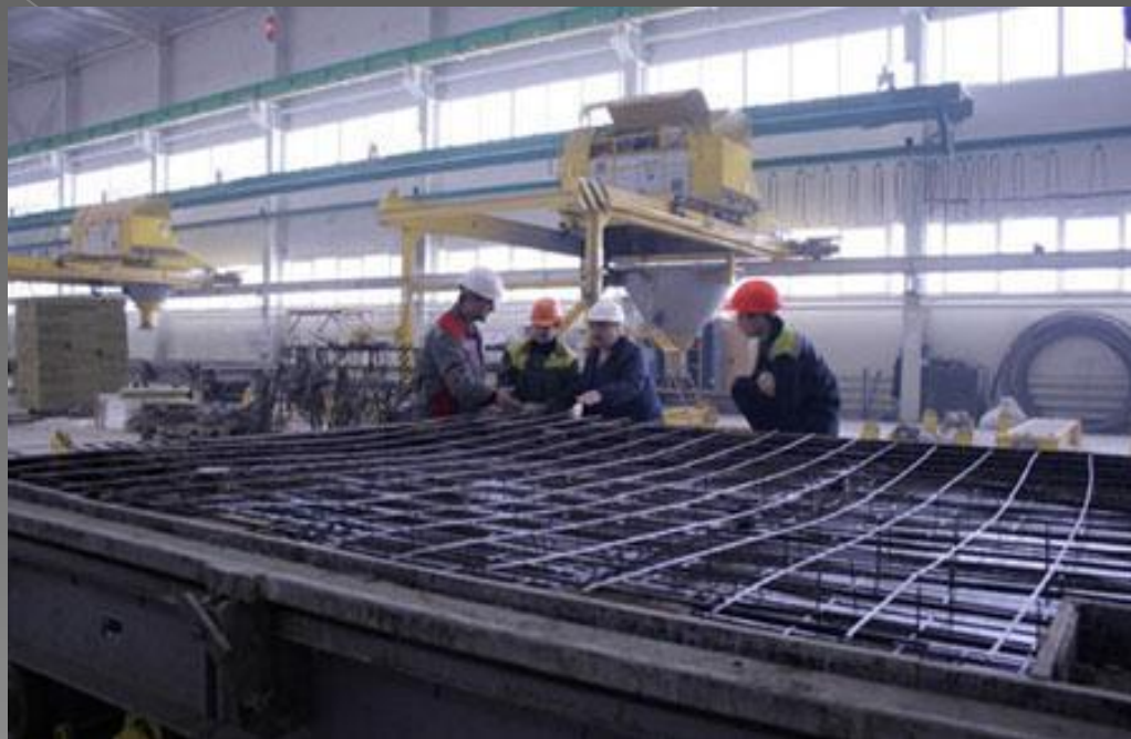
Установка арматурного каркаса
