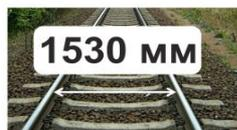
при радиусе от 349 м до 300 м (допуски -4 мм; +8 мм)
