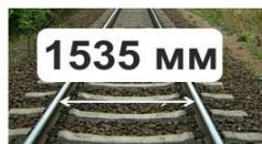
при радиусе от 299 м и менее (допуски -4 мм; +8 мм)
