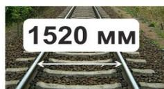
на прямых и на кривых радиусом 350 м и более (допуски -4 мм; +8 мм)
