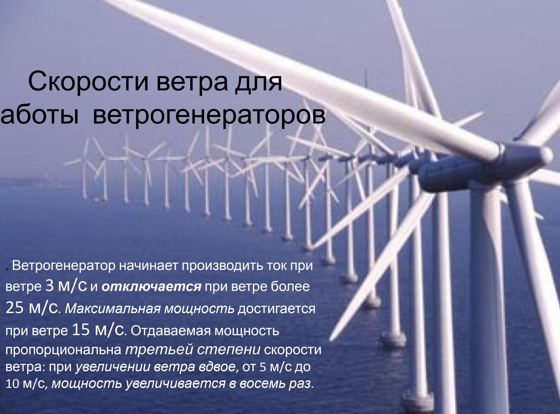
Ветрогенератор начинает производить ток при ветре 3 м/с и *отключается* при ветре более 25 м/с. Максимальная мощность достигается при ветре 15 м/с. Отдаваемая мощность пропорциональна *третьей степени* скорости ветра: при увеличении ветра вдвое, от 5 м/с до 10 м/с, мощность увеличивается в восемь раз.
