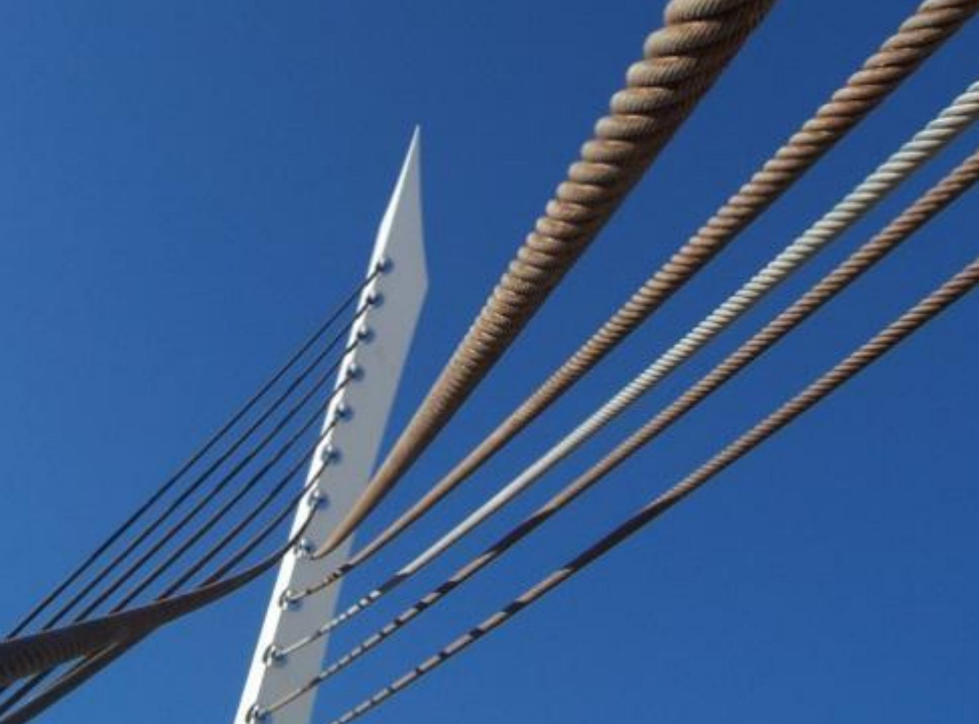
В вантовых мостах тросы делают предварительно напряжёнными, поэтому они предельно натянуты, не провисают и делают всё сооружение геометрически неизменяемым. При такой конструкции балка моста под проезжей частью может быть непривычно тонкой, поэтому вантовый мост является одним из самых экономичных и изящных мостов.
