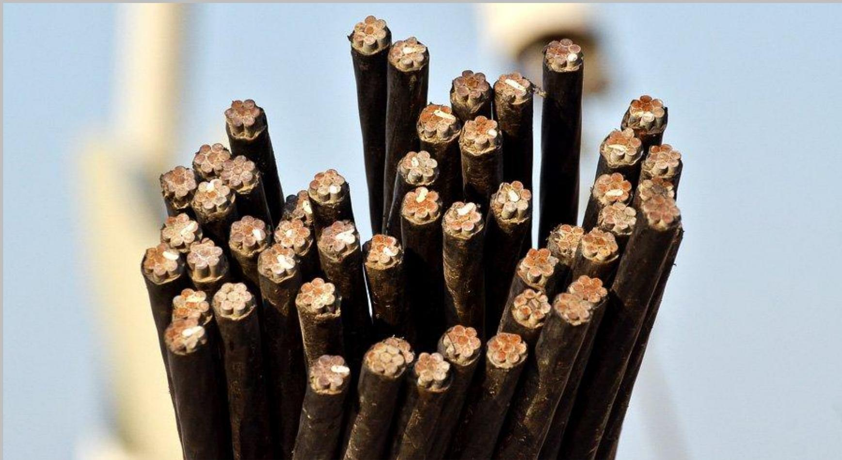
Оболочка вант выполнена из двух слоев: внутренняя — черного цвета, из полиэтилена высокой плотности, наружная — более тонкая
