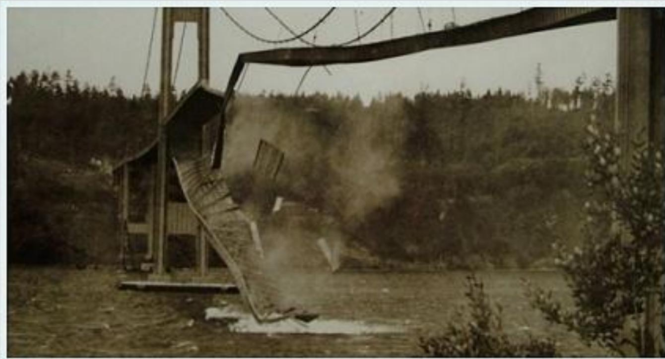
Особенностью висячих мостов является то, что несущие тросы, на которых держится вся конструкция, перекинутые через опоры (*пилон*), закрепляются на берегах. Вся конструкция держится на этих дугообразно провисающих между опорами тросах. При движении автомобилей по мосту тросы изменяют свою геометрическую форму, что вызывает прогибы и колебания пролётного строения. Поэтому всё большее распространение получает геометрически неизменяемый тип висячей конструкции – *вантовая конструкция*
