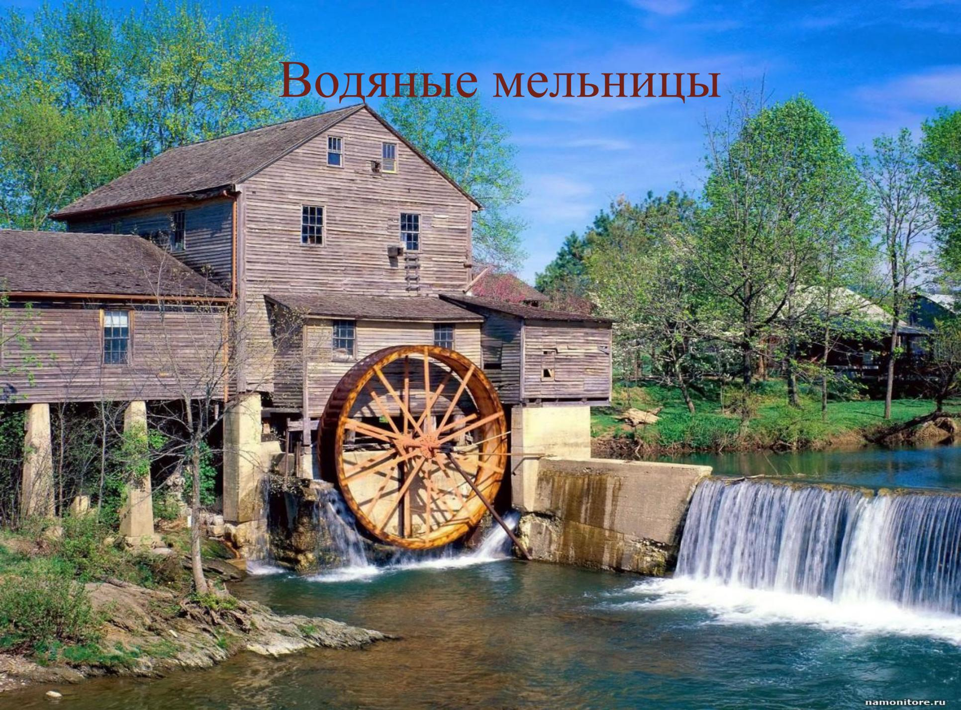
**Водяная мельница** — гидротехническое сооружение, использующее гидроэнергию, получаемую с водяного колеса, движение которого выполняет полезную работу посредством зубчатой передачи. Для усиления энергии воды реку перегораживают плотиной, в которой оставляют отверстие для струи воды, вращающей водяное колесо
