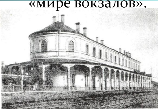
Здание "островного" вокзала первого класса. Архитектор Р.Желязевич. Вокзал в Бологом в 1870 надстроен вторым этажом в связи с увеличением движения поездов и расширением станции.
