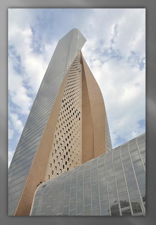
Закругленные углы башни выложены мозаикой из того же материала. Камень облицовки выполняет функции теплоизолятора, защищая здание от перегрева. На создание этой башни потребовалось 500 тысяч тонн цемента.
