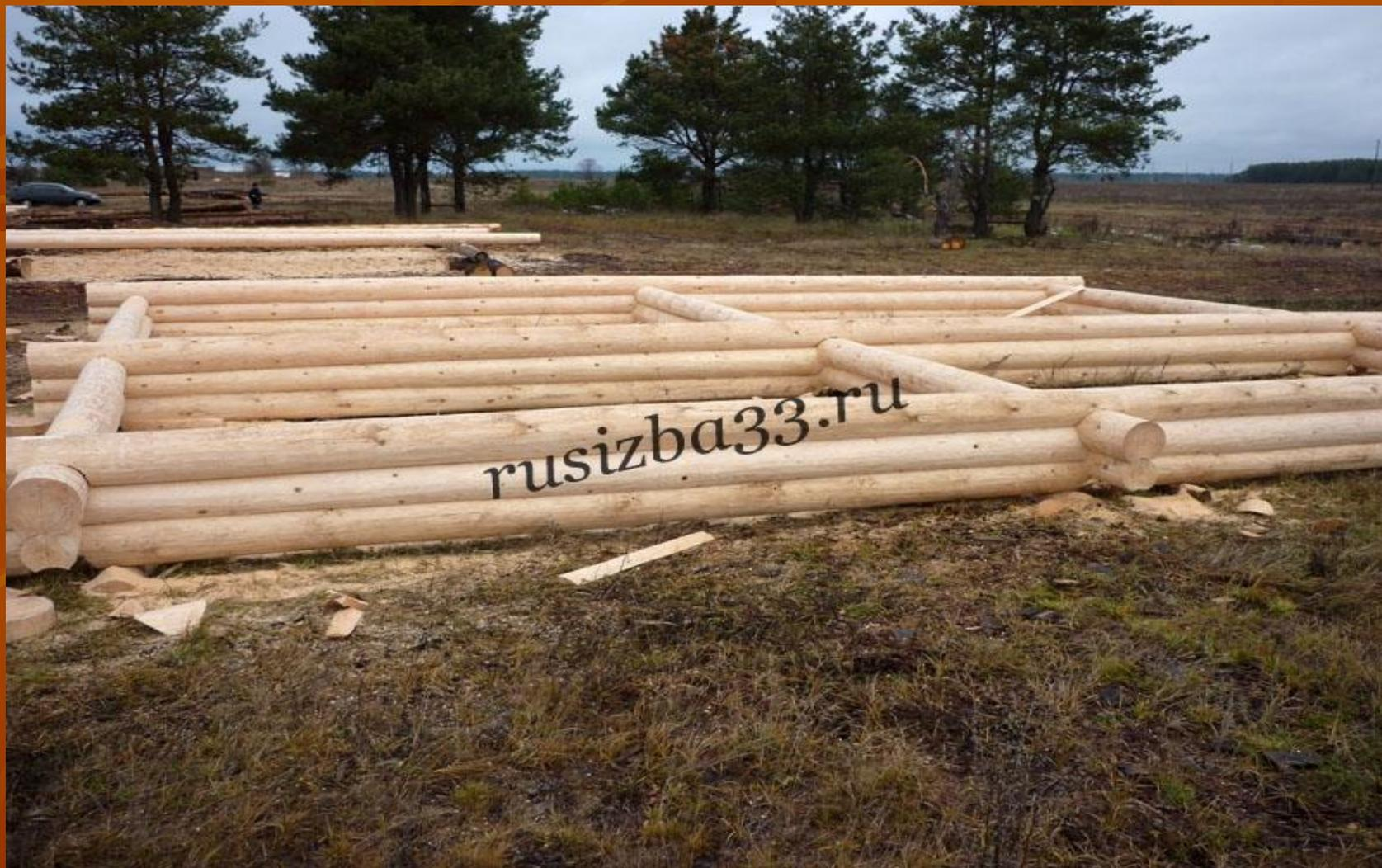
Их укладывают горизонтальными рядами и соединяют в углах врубками. Систему стен из брёвен, связанных между собой, называют срубом..
